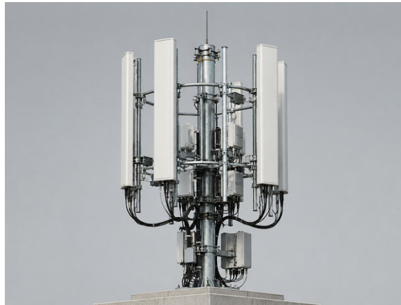
Figura 3.12: Una stazione radio base collega gli smartphone presenti nella cella alla rete dell'operatore.
